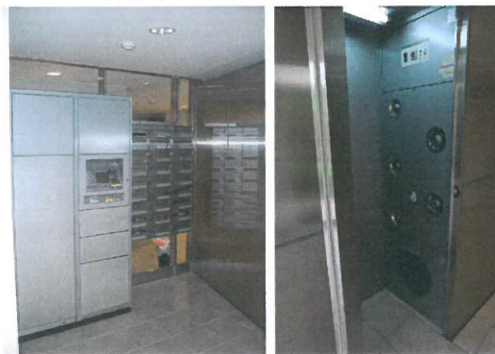
花粉症対策エントランス (風除室・空気清浄機・エアシャワー)
